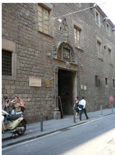
Exterior de la Biblioteca de Catalunya (c/ Hospital, 56, aquí visió de l'accés pel c/ Carme) . Foto: M. Josep R. Lucas
